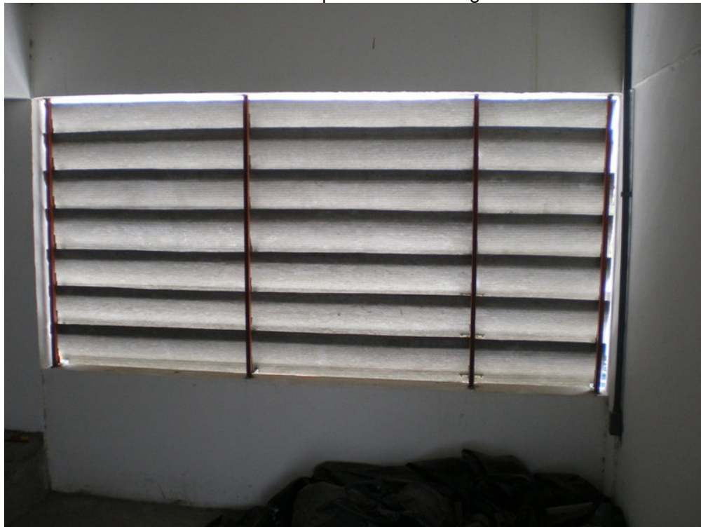
Foto 16 - Pavimento técnico coberto. Venezianas de fibrocimento instaladas para ventilação do reservatório superior e casa de máquinas.
