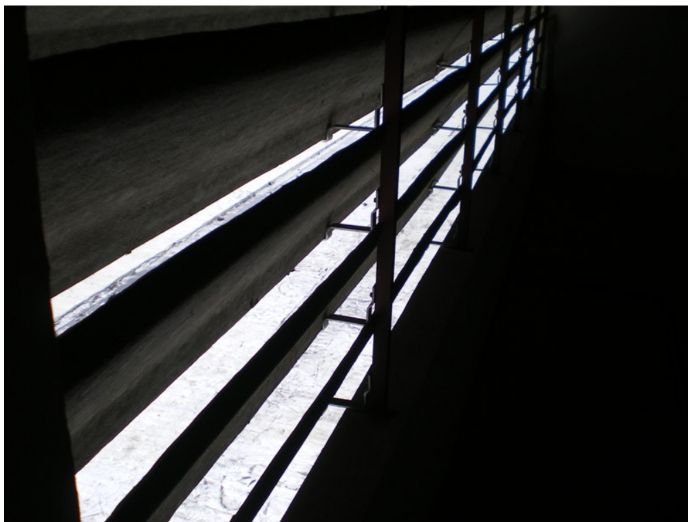
Foto 15 - Pavimento técnico coberto. Vãos entre venezianas de fibrocimento por onde entra água em dias de chuva e vento.
