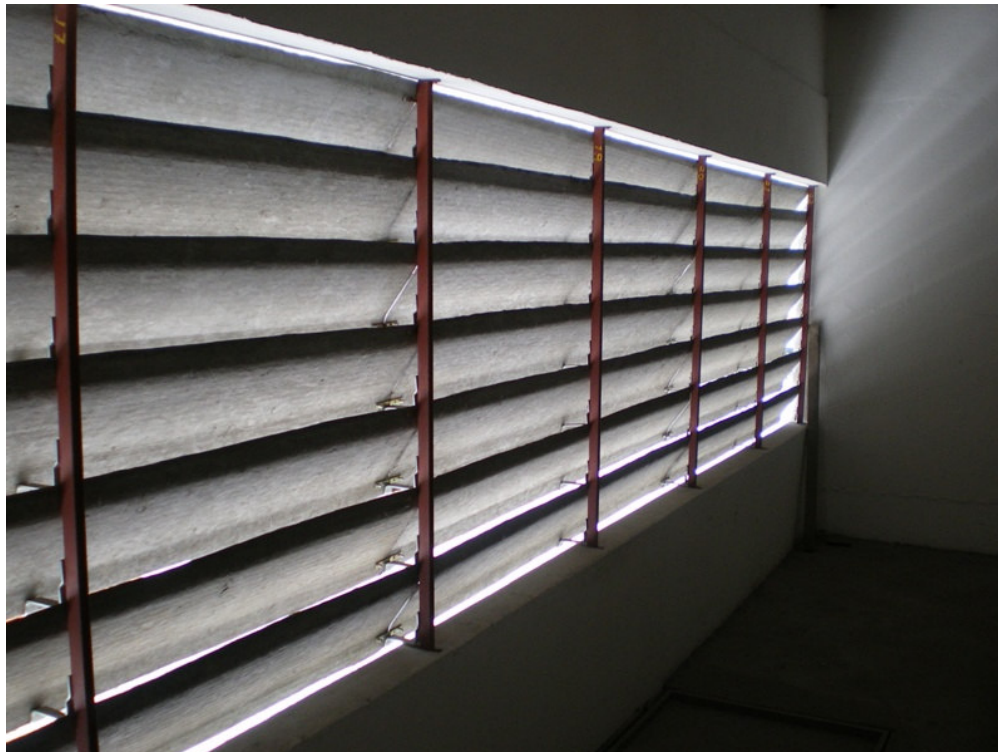
Foto 14 - Pavimento técnico coberto. Venezianas de fibrocimento instaladas para ventilação do reservatório superior e casa de máquinas.
