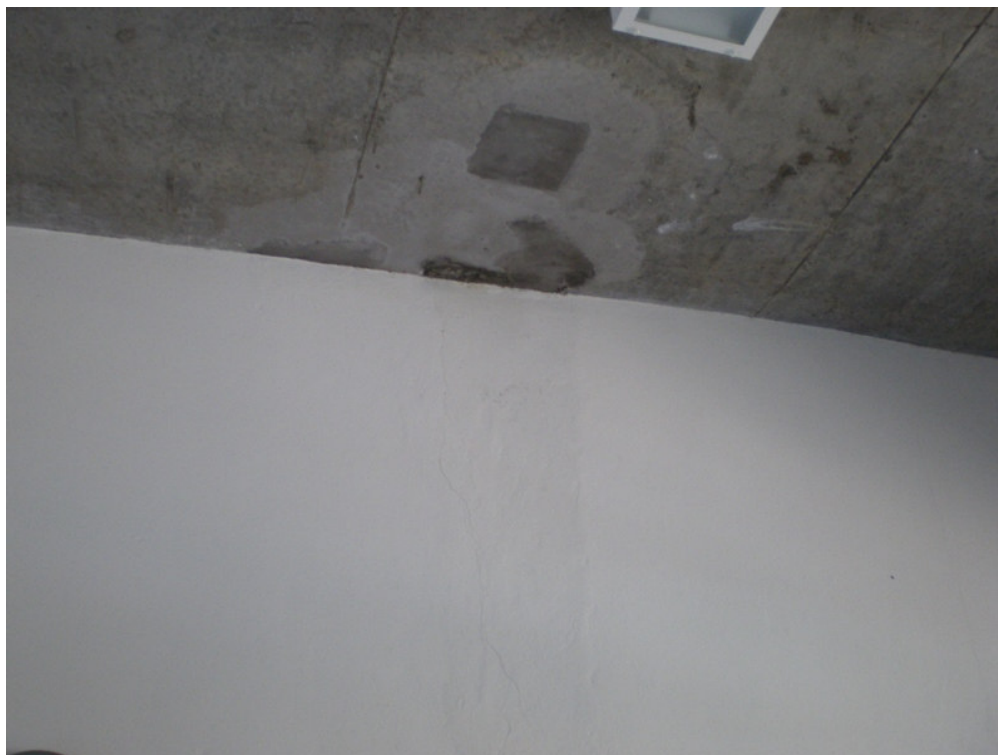
Foto 3 - Sala de reuniões - 3º pavimento Manchas de umidade no forro e parede, devido a infiltrações na cobertura
