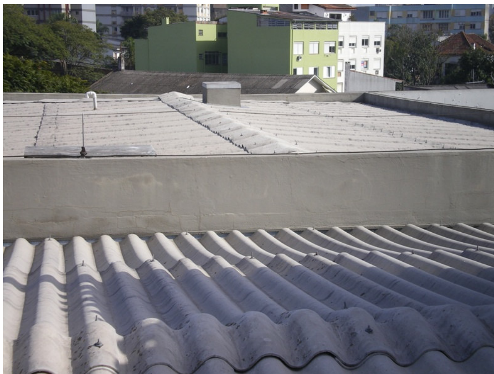
Foto 8 - Cobertura com telha de fibrocimento Trespasse insuficiente devido a baixa inclinação.
