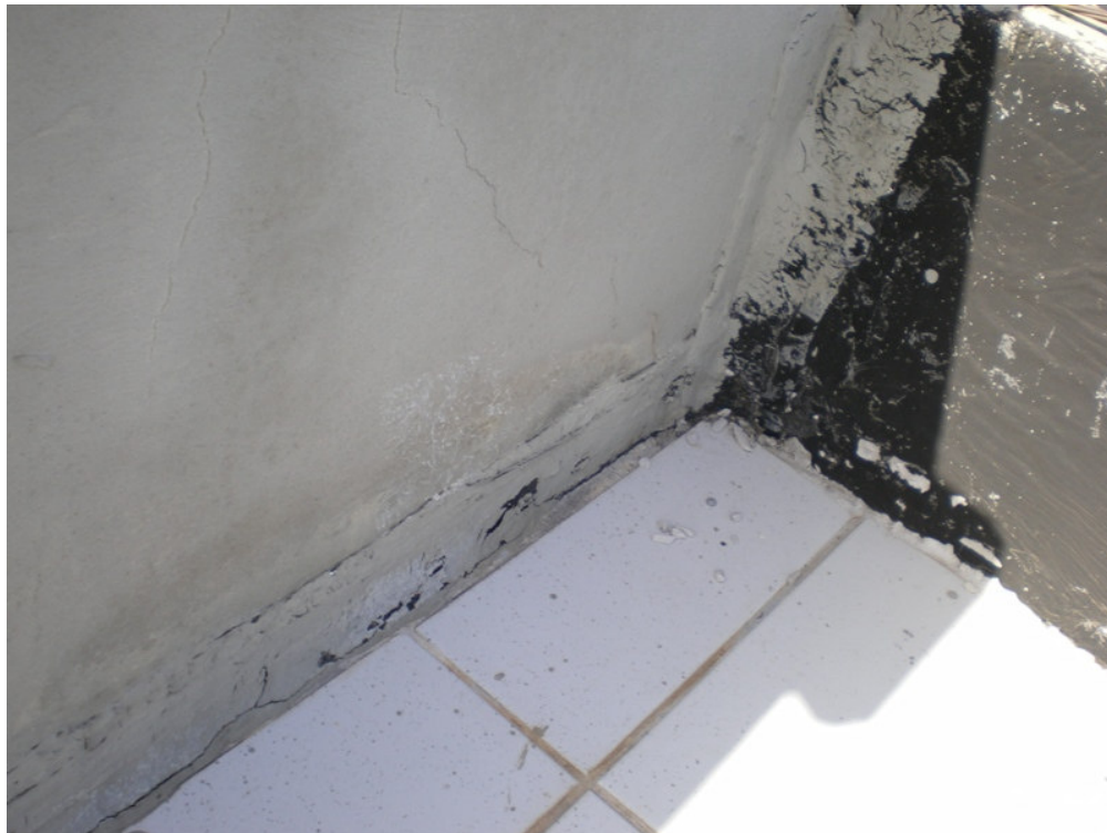
Foto 10 - Má execução da impermeabilização nas arestas de encontro das lajes descobertas com as platibandas
