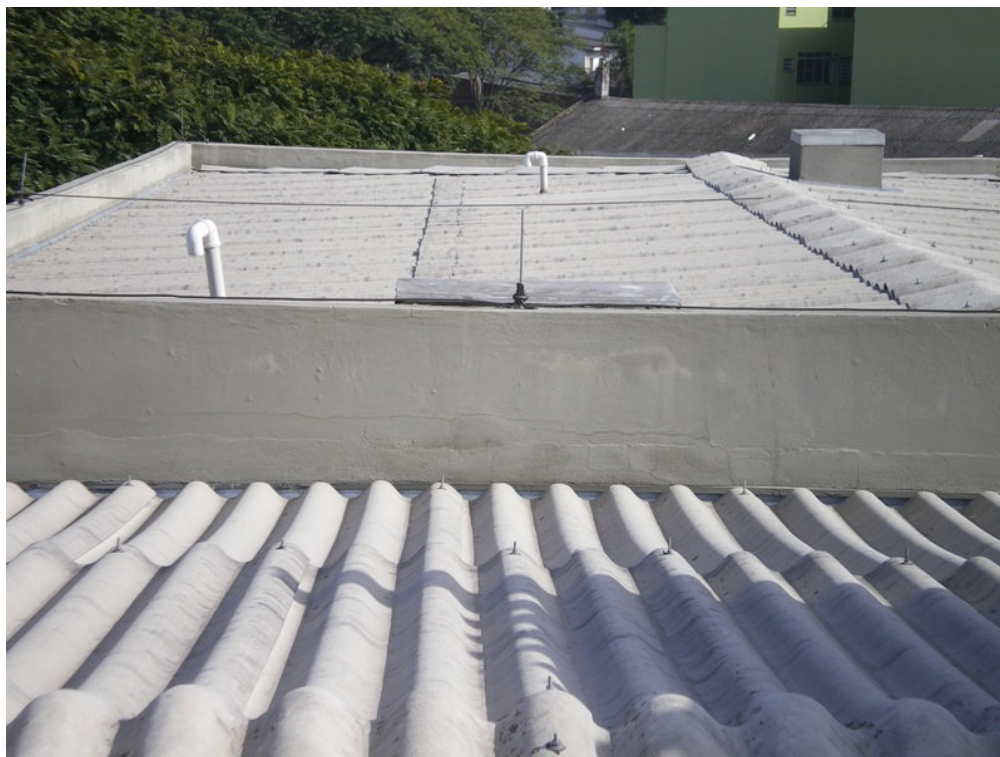
Foto 9 - Cobertura com telha de fibrocimento Trespasse insuficiente devido a baixa inclinação.
