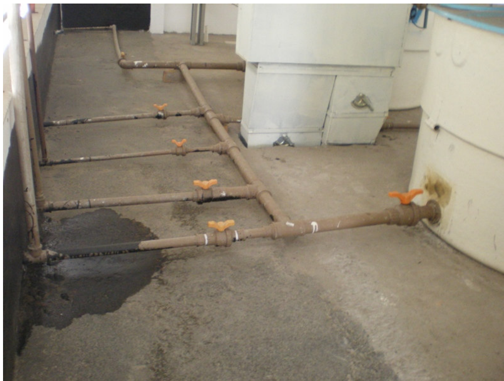
Foto 13 - Pavimento técnico coberto. Manchas de umidade no piso devido a entrada de água entre os vãos das venezianas de fibrocimento.
