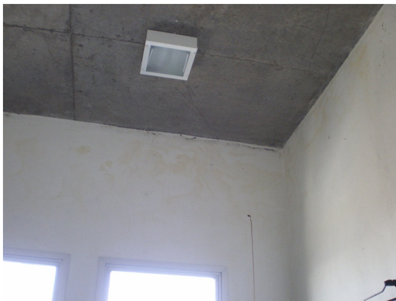
Foto 1 - Sala de reuniões - 3º pavimento Manchas de umidade no forro e parede, devido a infiltrações na cobertura
