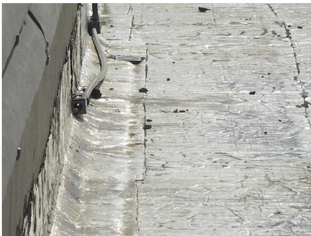
Foto 6 - Laje da cobertura Impermeabilização com manta asfáltica aluminizada sobre o piso cerâmico original. Reparo sobre o piso existente. Problemas de colagem no encontro da laje com a platibanda.
