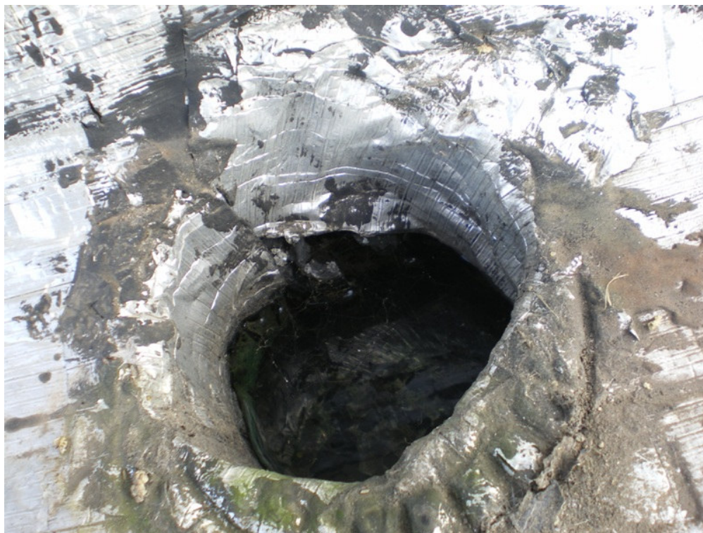
Foto 7 - Laje da cobertura Impermeabilização com manta asfáltica aluminizada sobre o piso cerâmico original. Problemas no acabamento do ralo.
