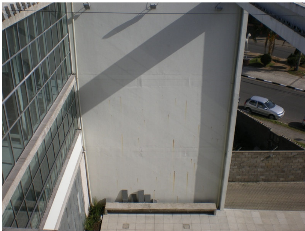
Foto 17 - Parede externa em concreto armado Manchas de ferrugem devido a baixa espessura do recobrimento da armadura.
