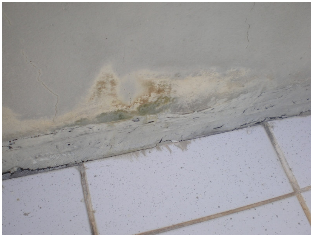
Foto 11 - Má execução da impermeabilização nas arestas de encontro das lajes descobertas com as platibandas
