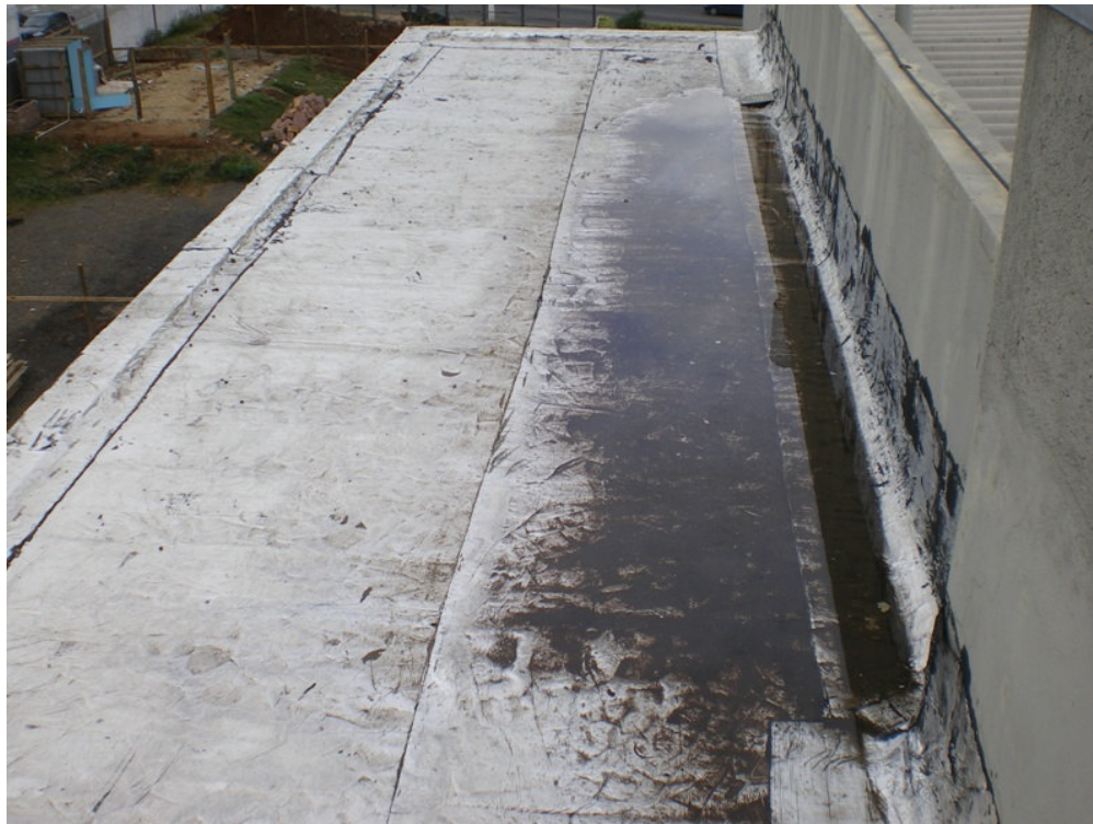
Foto 4 - Laje em balanço na cobertura Má execução no caimento da laje acarretou no empoçamento constante de água na superfície e infiltração no pavimento inferior
