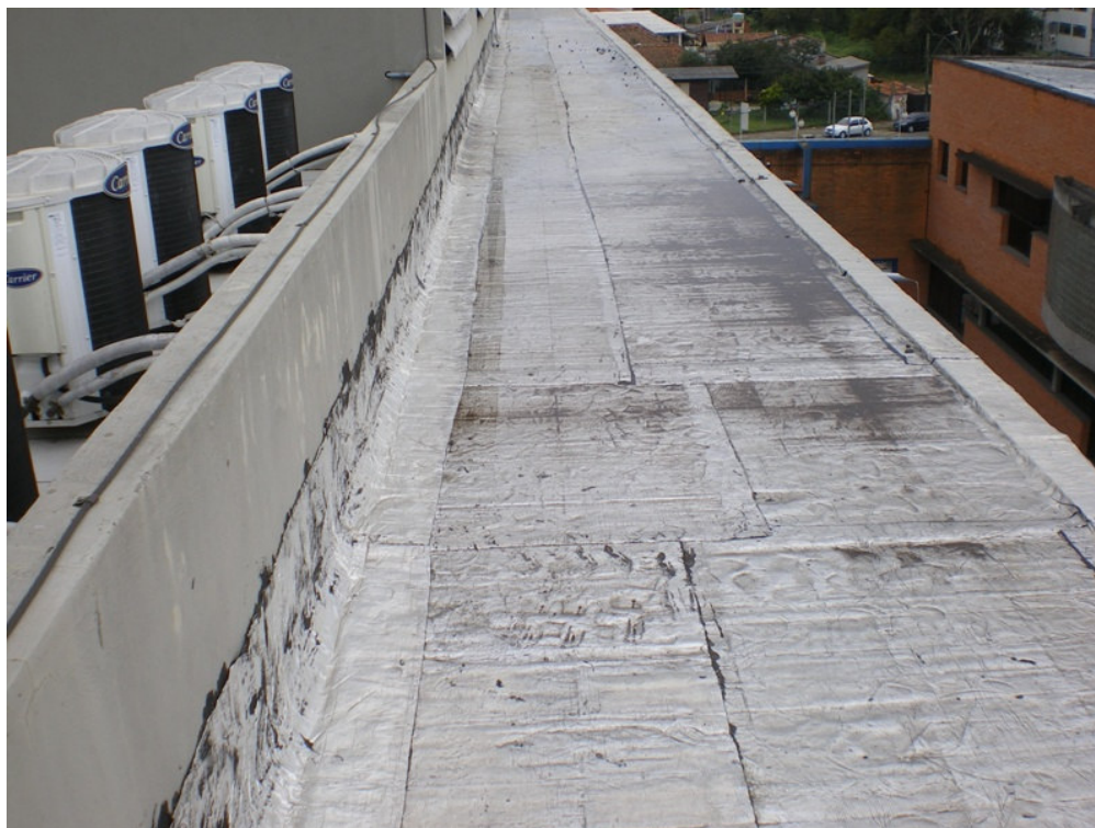
Foto 5 - Laje em balanço na cobertura Impermeabilização com manta asfáltica aluminizada sobre o piso cerâmico original.
